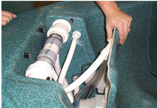
(Figure P) Removing a JetPak
